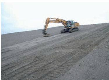
Deponie Hohberg: Trag- und Stützschi- cht unter der Oberflächenabdichtung
