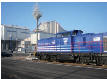
Gewerbepark Breisgau: Schlacke als Frostschutz- schicht unter Asphalt der Bahnverladestraße
