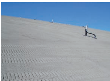
Deponie Hüfingen: Grobschlacke als Gas- drainageschicht, darüber Feinschlacke als Schutz- schicht unter KDB
