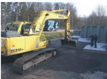
Recyclinghof Burghof: Schlacke als Frostschutz- schicht unter Asphalt
