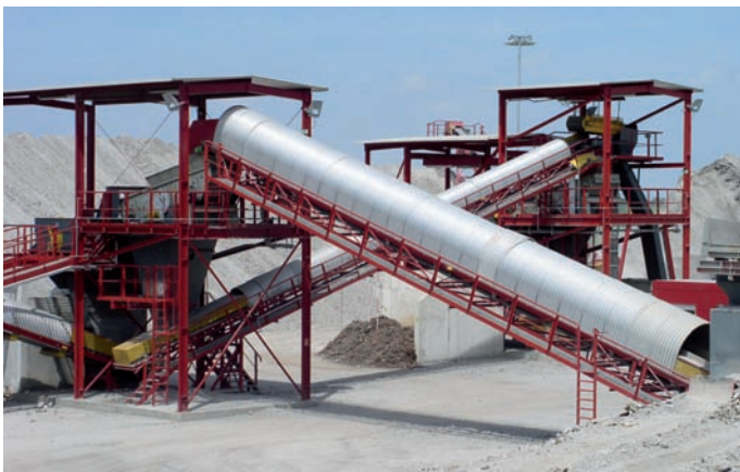
Aufbereitungsanlage im Gewerbepark Breisgau
